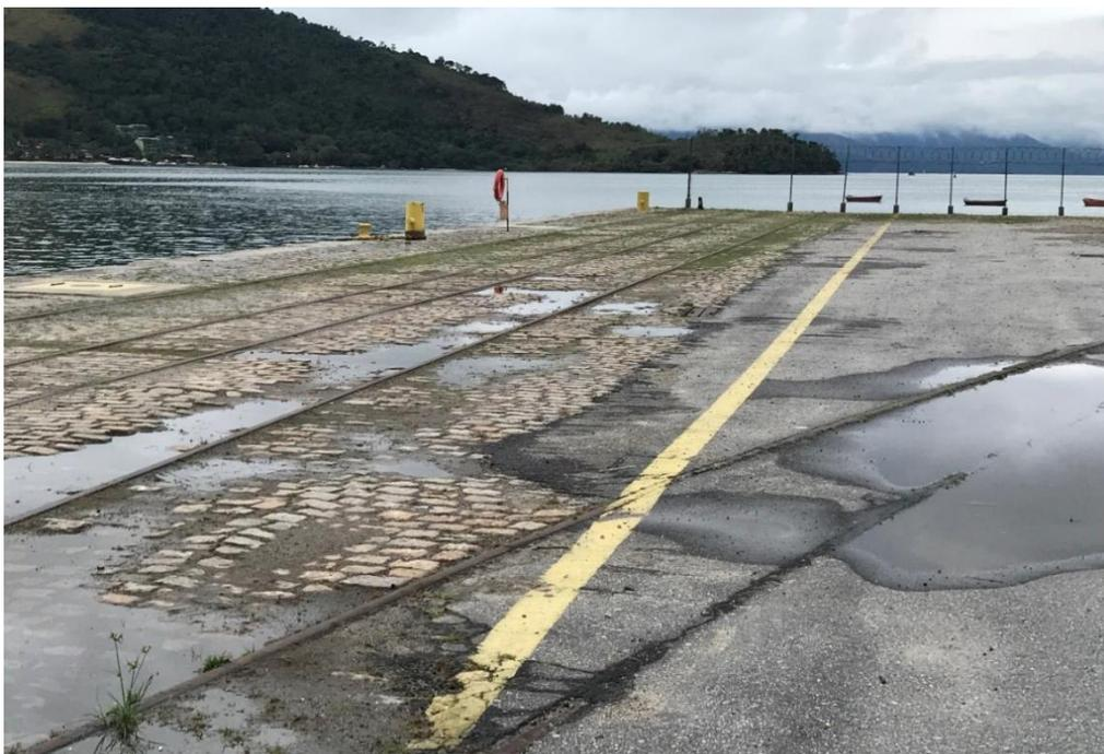
Figura 45 – Situação atual das vias ferroviárias internas do Porto de Angra dos Reis – trecho encoberto por pavimentação asfáltica
