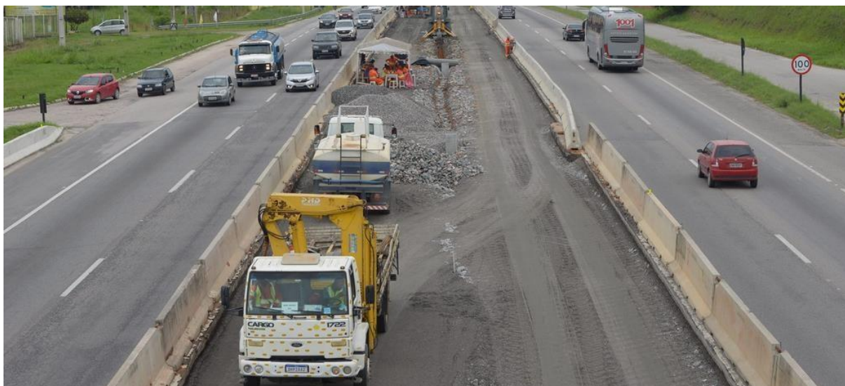
Figura 20 - Obras na rodovia BR-101/Norte
