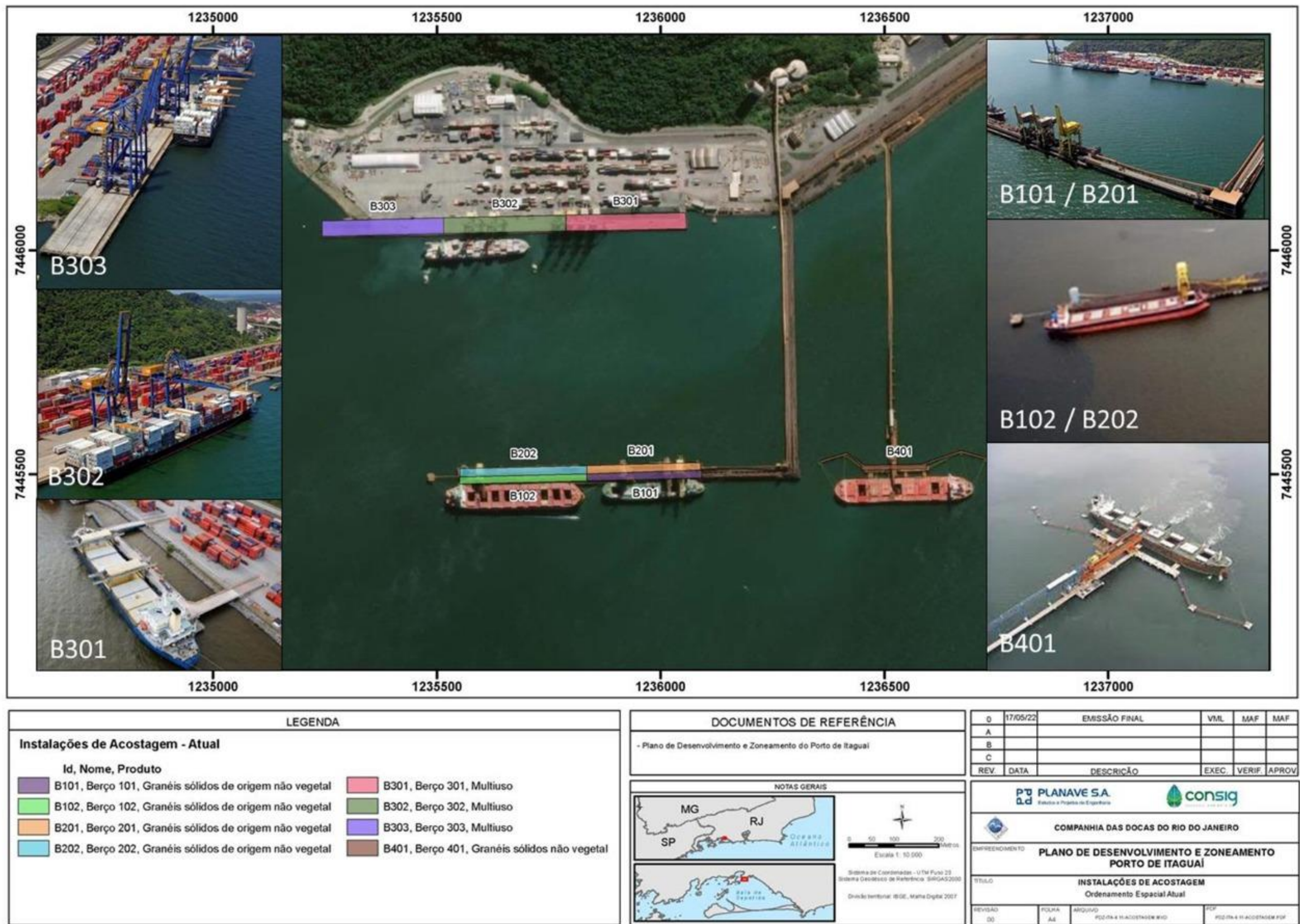
Figura 8 – Imagens das Instalações de Acostagem do Porto de Itaguai durante Visita Técnica – Situação Atual
